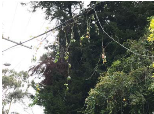
Curubas enredadas en cables de la luz
