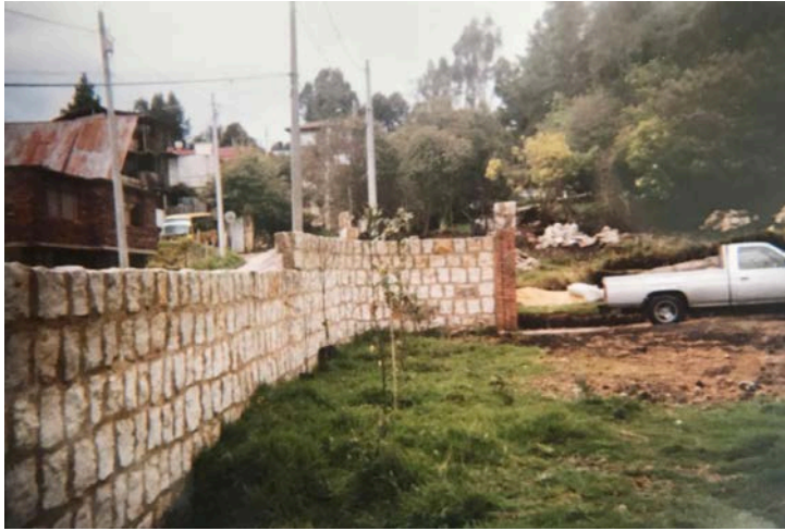
Vista del muro construido
